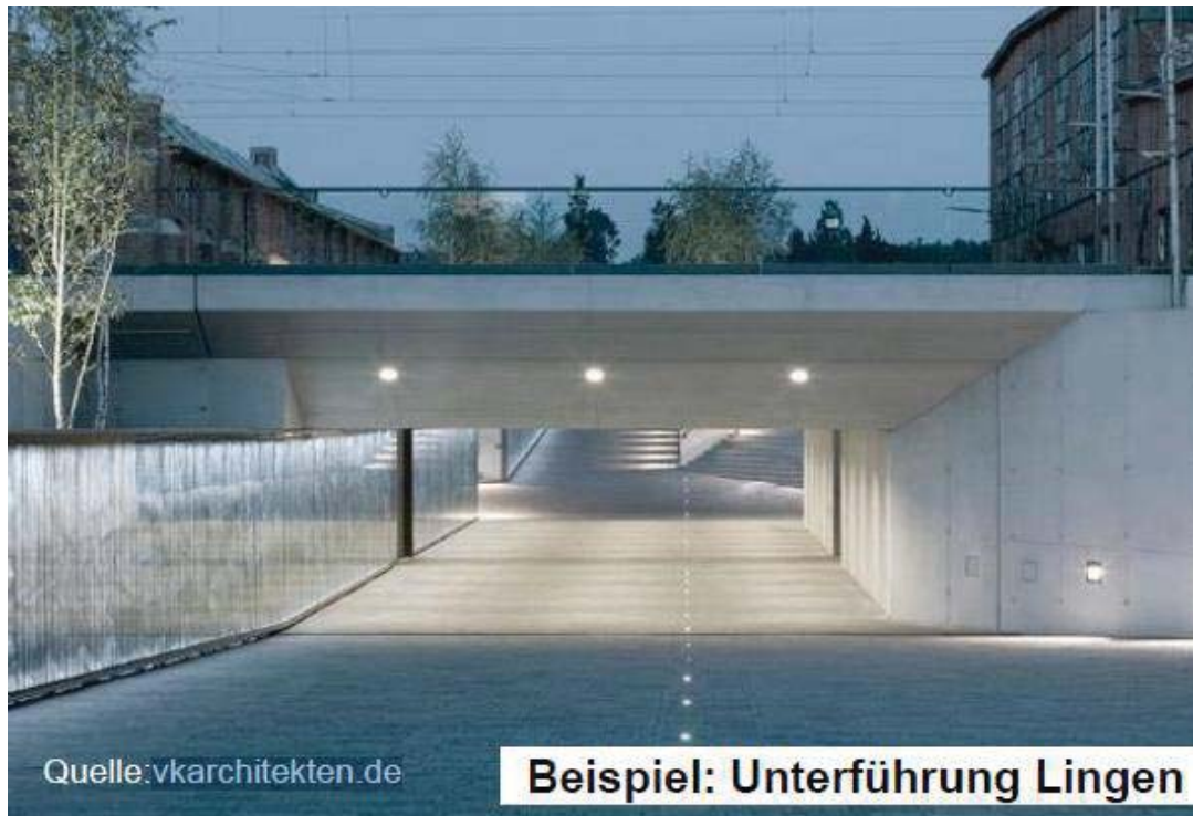
Abbildung 7: Beispiel für ein gelungenes Unterführungsbauwerk, Bahnhof Lingen
